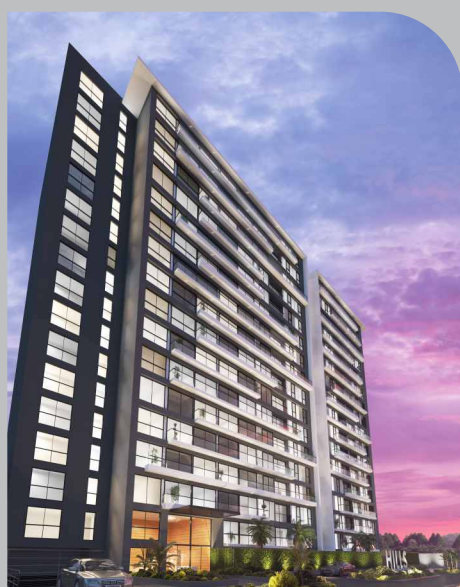
EDIFICIO HILLS SURCO
